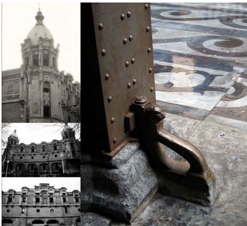
Exterior de la Alhóndiga en su estado de abandono y detalle de una de las puertas de acceso.
