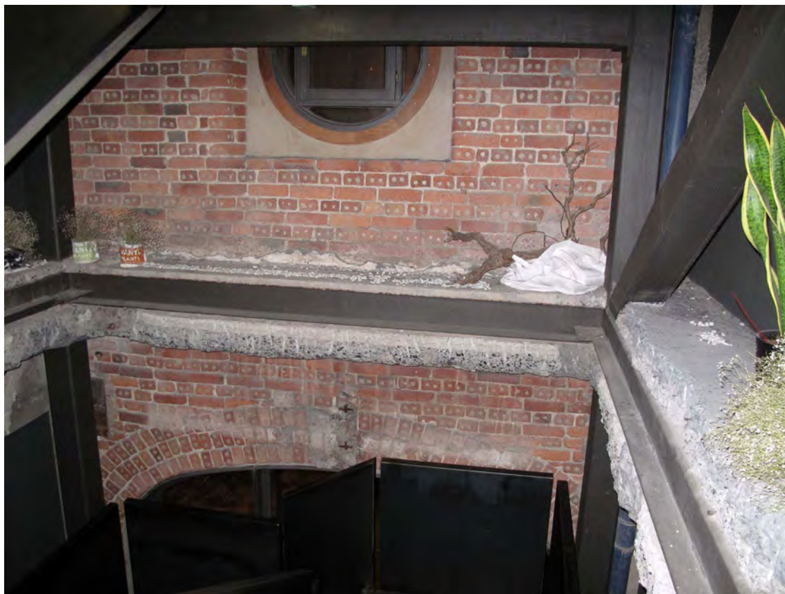
Hueco de escaleras hacia los pisos superiores y a la terraza habilitada como zona estancial.
